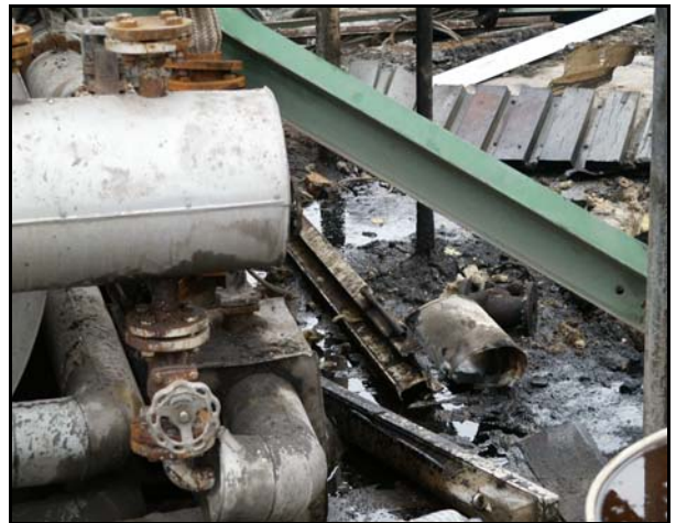
Abbruch einer Industrieanlage
