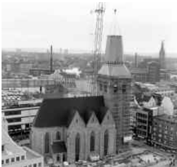
1981 wurden die einzelnen Segmente des neuen Turmhelms auf der Petrikirche angebracht.
