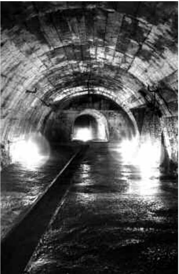
Blick in den Tiefstollen, der sich westlich vom Stadtkern befindet.
