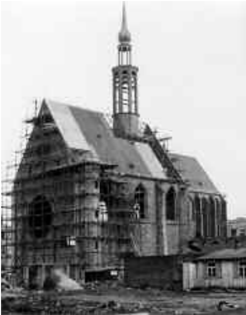
Wiederaufbauarbeiten an der Propsteikirche. Der neue, stählerne Dachreiter ist aufgerichtet und die Fensterrose an der Westseite ist bereits zu erkennen.
