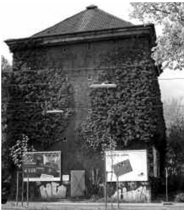
Hochbunker in Dortmund-Hörde, Faßstraße
