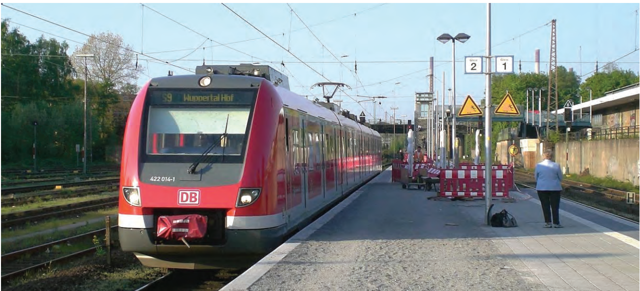
Abb. 41: Ein Zug der Linie S9 im Bahnhof Gladbeck-West. Im Rahmen des S9-Ausbaus wird der Bahnhof modernisiert und erhält eine barrierefreie Ausstattung.
