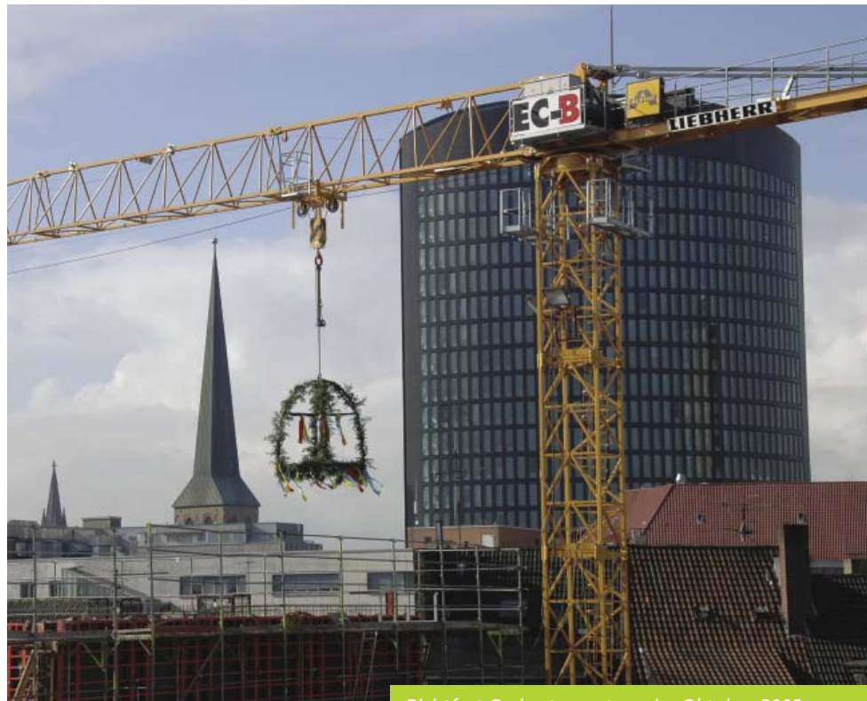
Richtfest Orchesterzentrum im Oktober 2008
