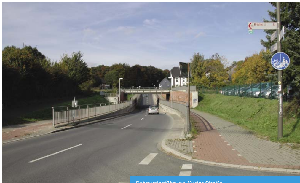
Bahnunterführung Kurler Straße
