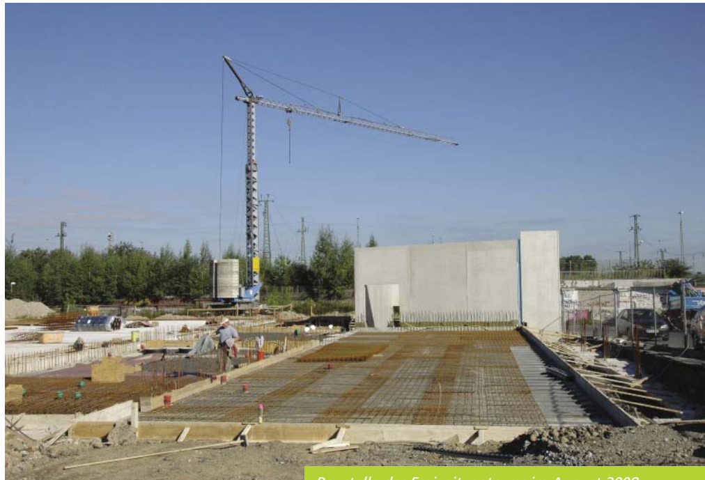
Baustelle des Freizeitentrums im August 2008
