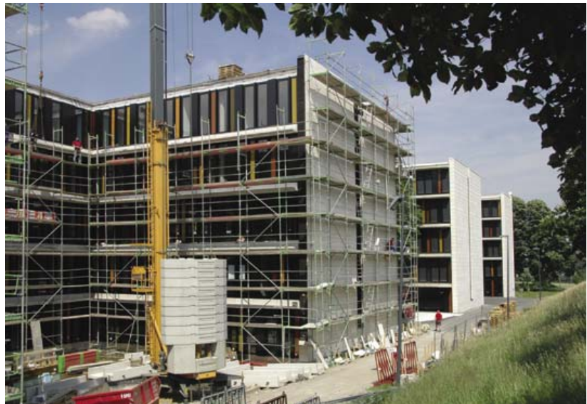
ADAC-Gebäude 2. Bauabschnitt (Juni 2008)
