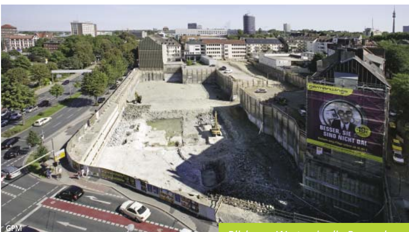
Blick von Westen in die Baugrube
