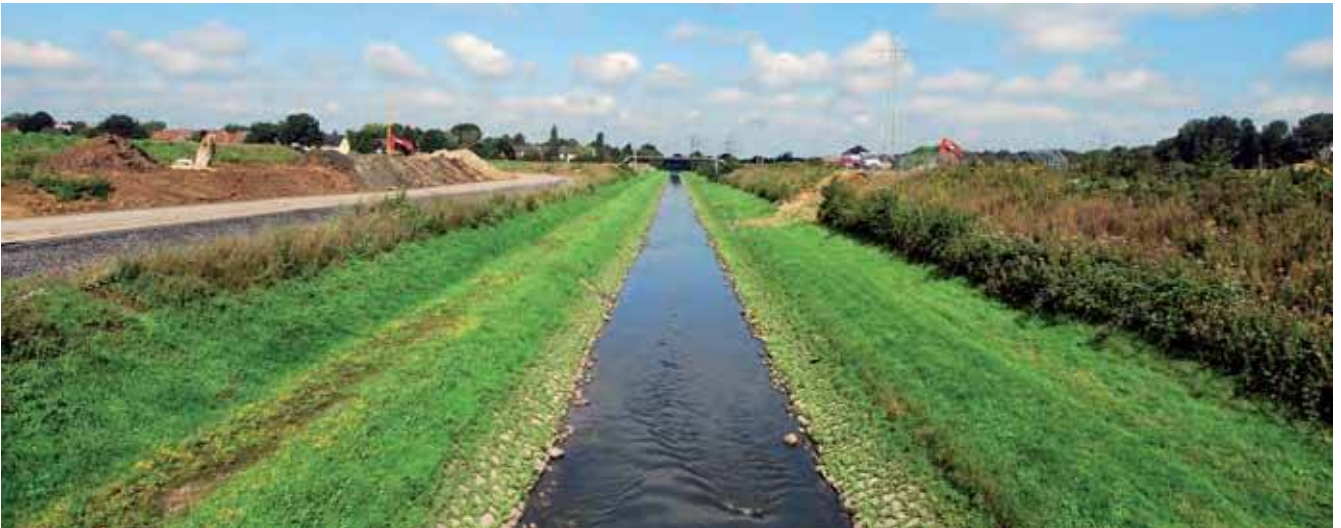
Abb.: Emscherumbau in Dortmund | EG
