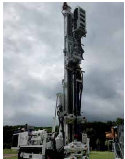
Abb.: Probebohrung | GZB
