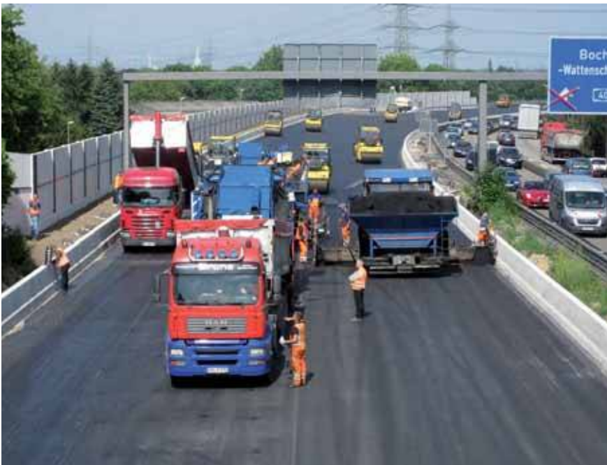
Abb.: Einsatz von offenporigem Asphalt zur Lärminderung auf der A 40 | Straßen.NRW
