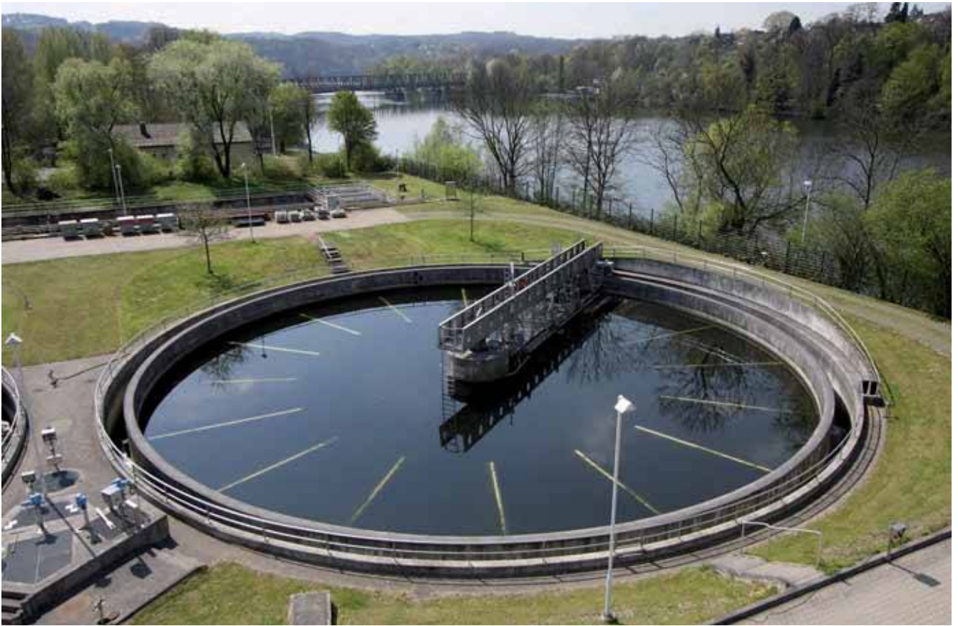
Abb.: Kläranlage Essen-Kupferdreh | Ruhrverband
