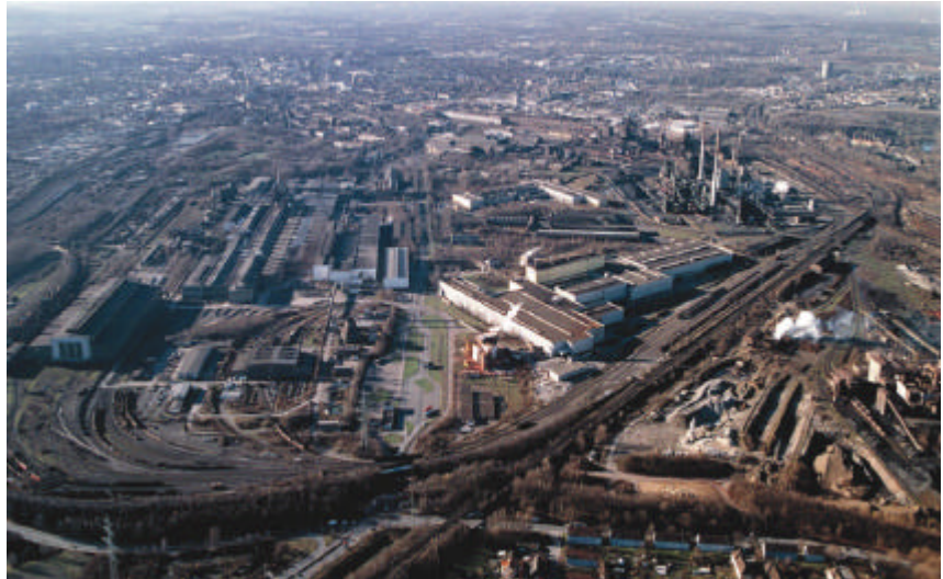
Schrägaufnahme Luftbild Westfalenhütte
