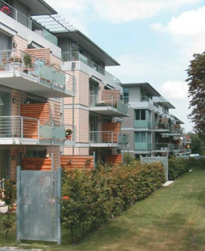
Ursulastraße, Essen: städtebaulich, architektonisch, gestalterisch, sozial und ökologisch beispielgebende Wohnbebauung
