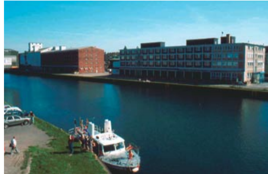
Dortmunder Hafen mit Lagergebäude
