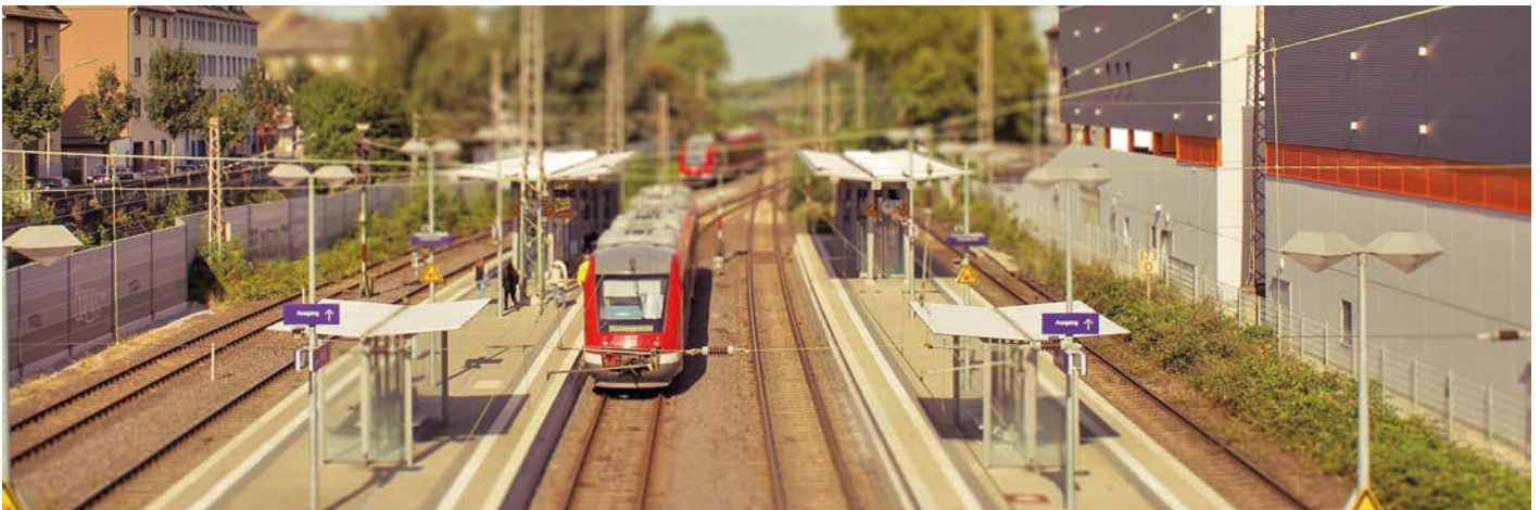
Hörde ist ein regionaler Verkehrsknotenpunkt und daher besonders anfällig für die Folgen von Starkregen. Foto: Mathias Beckmann/pixabay.com
