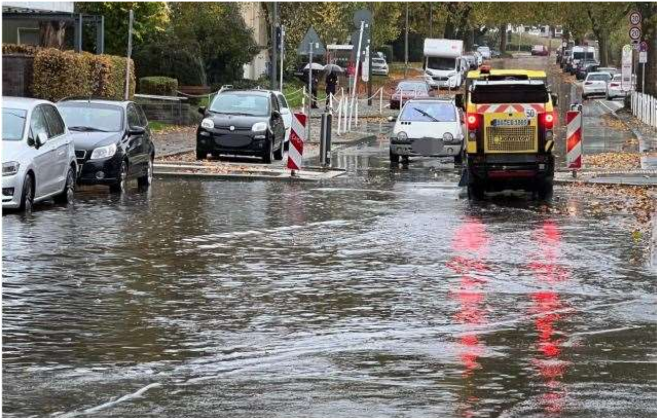
Im Bereich von Kuithan- und Haldenstraße stehen derzeit einige Straßenabschnitte unter Wasser. © Uwe Kisker
