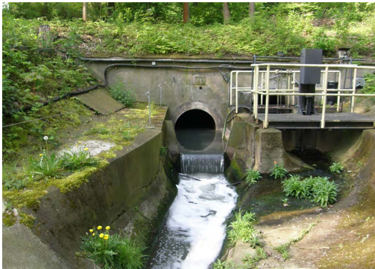
Abb. 36: Einleitung in den Rüschebrinkgraben im Nordosten des Untersuchungsraumes (Zustand 2014)
