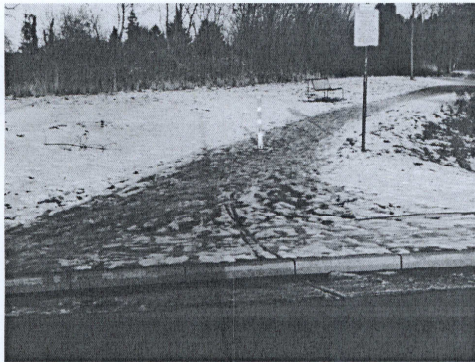
Fehlende Bordsteinabsenkung an der Straße „Stadtgärtnerei“ und falsche Beschilderung. Foto: K.-H. Kibowski
