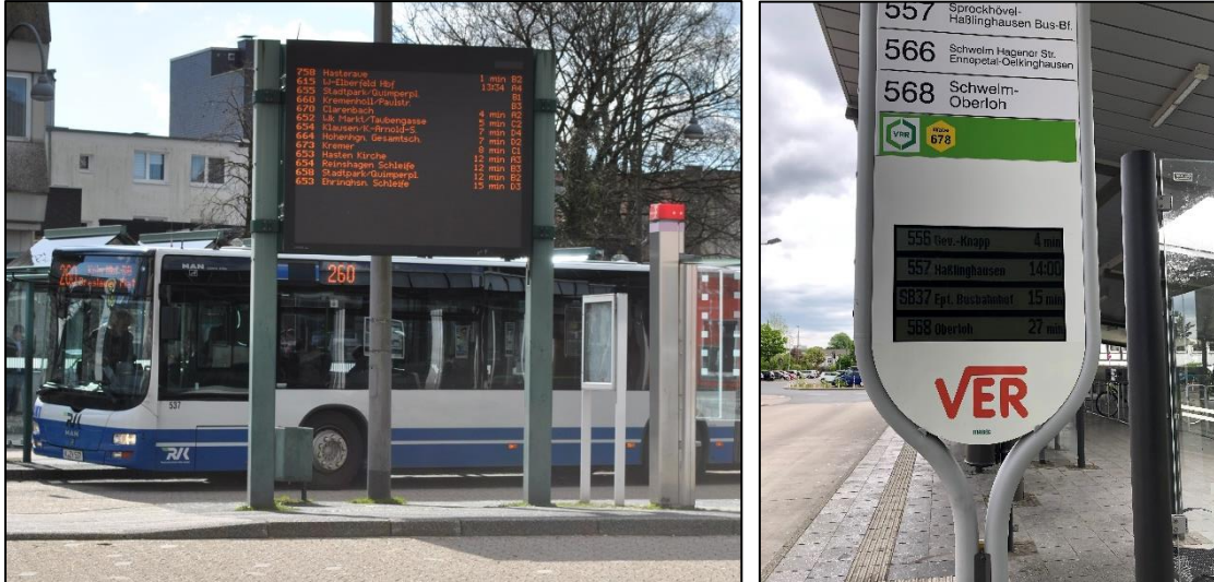
Abbildung 7: Beispiel DFI-Anlage, Friedrich-Ebert-Platz Remscheid (links) und Schwelm Bf (rechts) (eigene Fotos)
