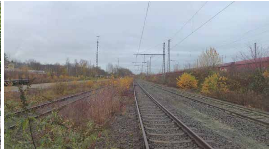
Blick auf die Flächen des Güter- und Containerbahnhofs
