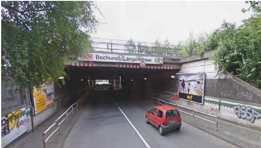
Brückenbauwerk am S-Bahnhof Langendreer
