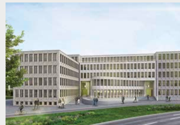
Ebenfalls im Umfeld des PHOENIX Sees wird das Südtor errichtet
