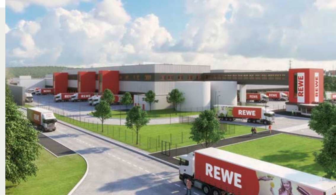
Das neue Frischezentrum von REWE schont dank modernem Energiemanagement Umwelt und Ressourcen
