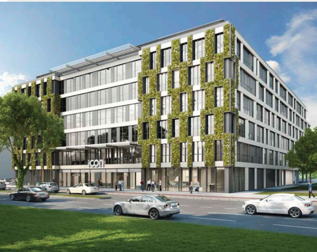
So soll es aussehen: Das Icon am Rheinlanddamm trägt den Nachhaltigkeitsgedanken mit begrünter Fassade nach außen
