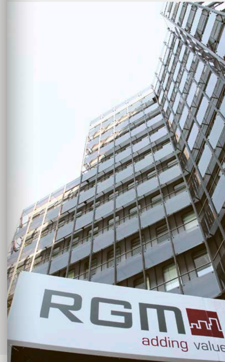
Die Unternehmenszentrale der RGM Holding GmbH liegt im Hansa Haus in der Dortmunder City
